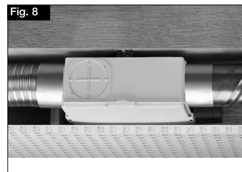
Montage en faux-plafond directement dans le réseau de gaines (**avec support de montage**).
