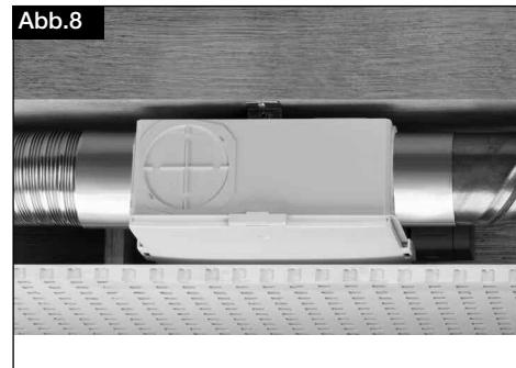
Montage in abgehängter Decke.
